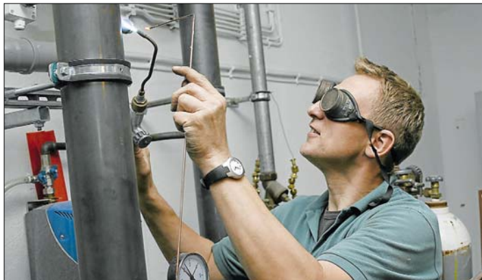
Passt, wackelt und hat Luft: Folke Klann von der Beckumer Firma Leifhelm & Pelkmann installiert die Heizung im Gebäude der Ketteler-Schule. Bilder: Ackfeld
