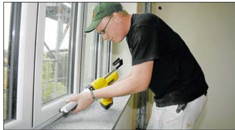
Die Fensterbank versiegelt Stefan Schorn von der Firma Fliesen & Kamine Liekenbröcker.
