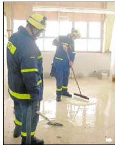
Schaden in sechsstelliger Höhe entstand in der Kettelerschule.
